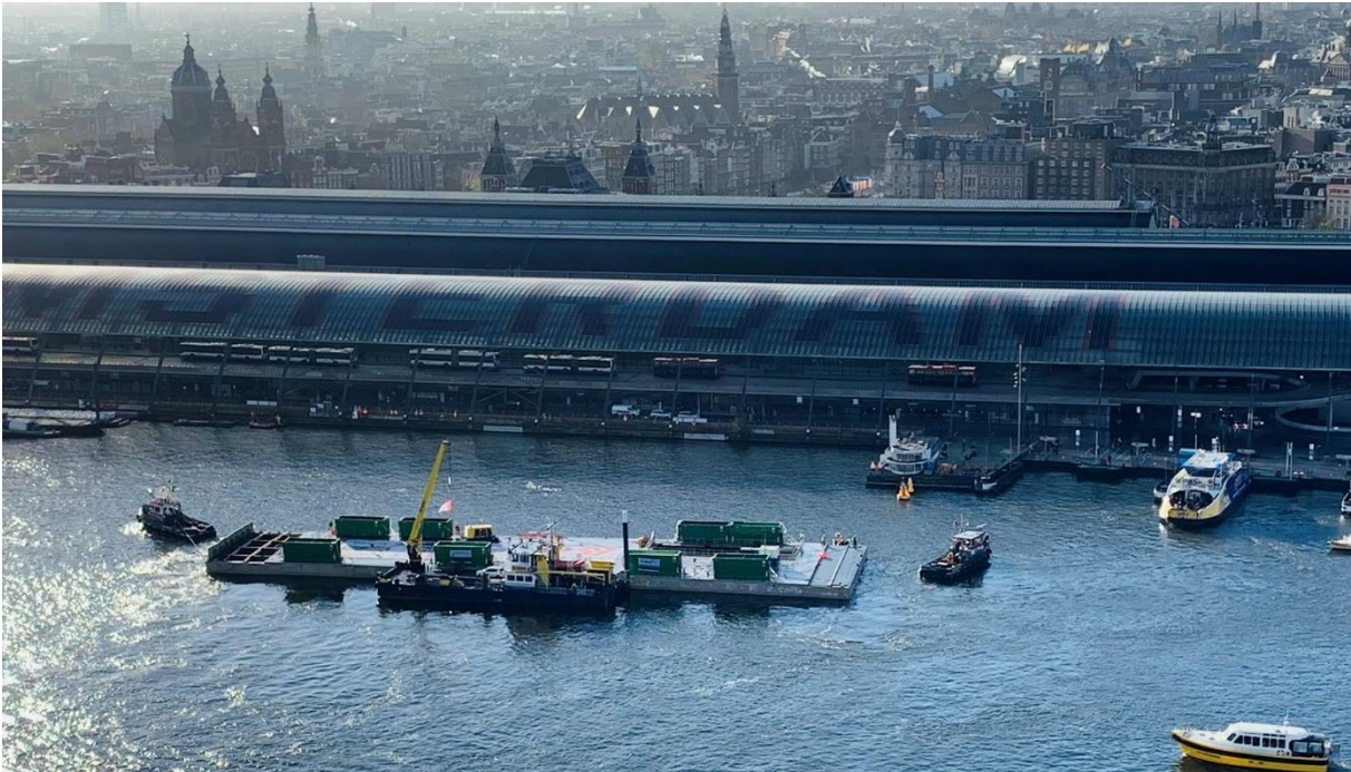
Foto 11 Invaren element West met op het dak de (lege) watertanks
