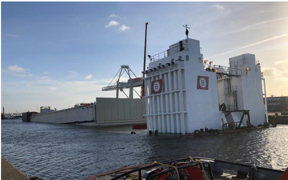
Foto 9 Float-Off een van de elementen
