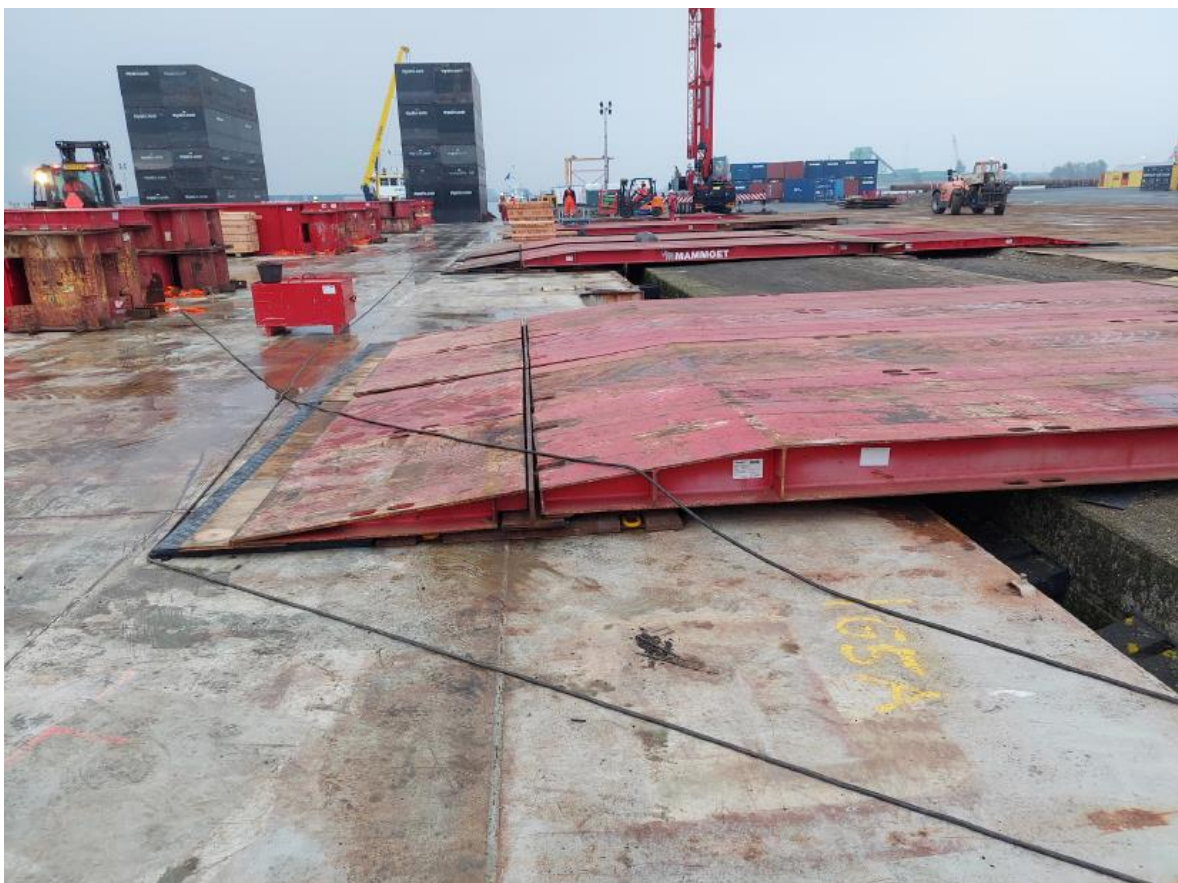
Foto 7 Het buitenste deel van kade is met behulp van schotten overbrugd
