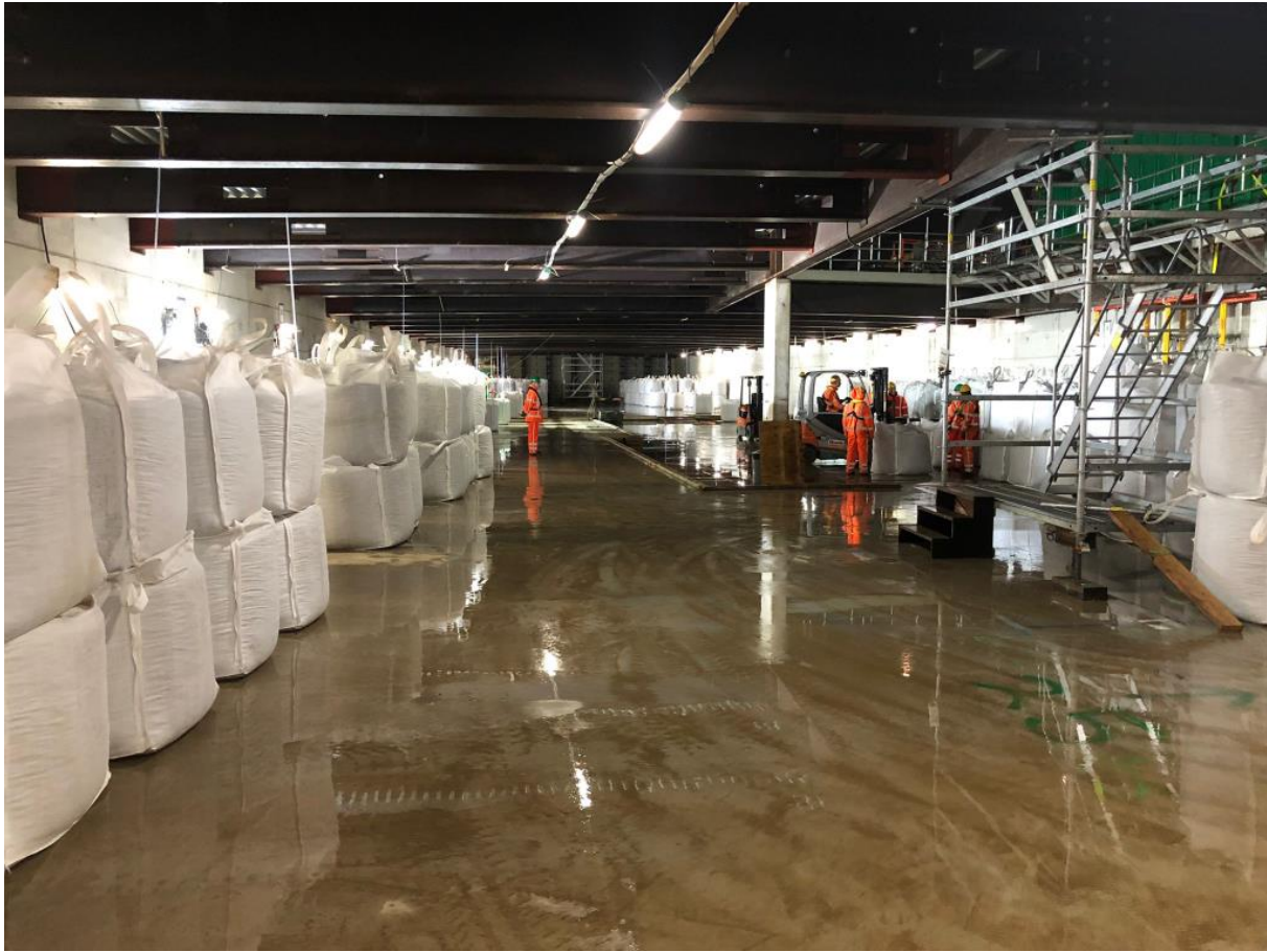
Foto 12 Aanbrengen ballast met big bags en ballastwater
